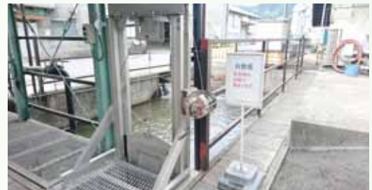
■最終放水口-自動堰
