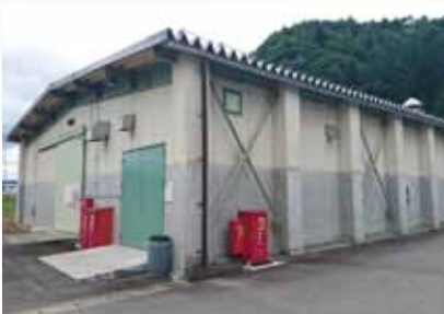
■危険物保管庫
