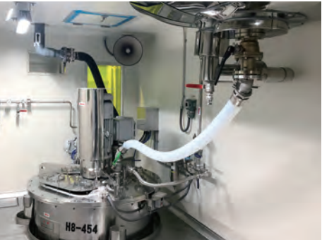
老朽化設備更新及びスケールアップによる生産効率の改善
