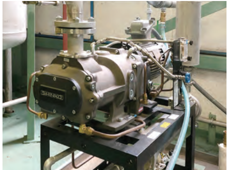
ドライ真空ポンプ導入によるメタノール含有排水削減
