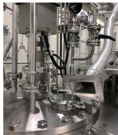
溶媒タンクの点検口の局所排気口
