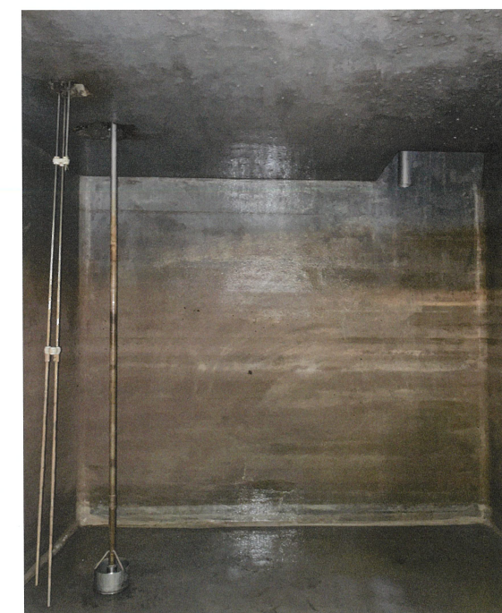
【清掃後Pピット内部】
